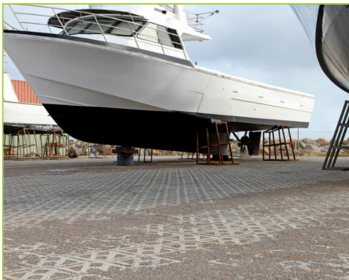
PERMEABLE PAVING FOR 300 TON BOAT LIFTER OPERATION
